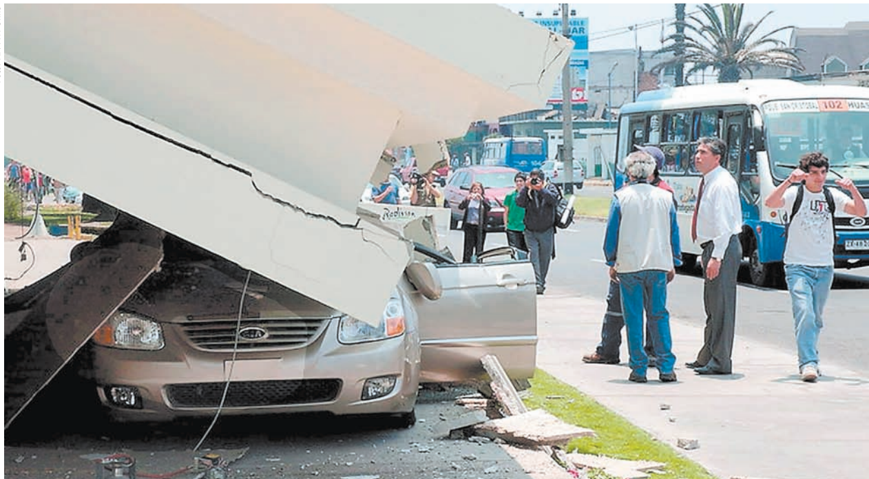
Daños en la estación de televisión TVN como consecuencia del sismo que sacudió el norte de Chile.
